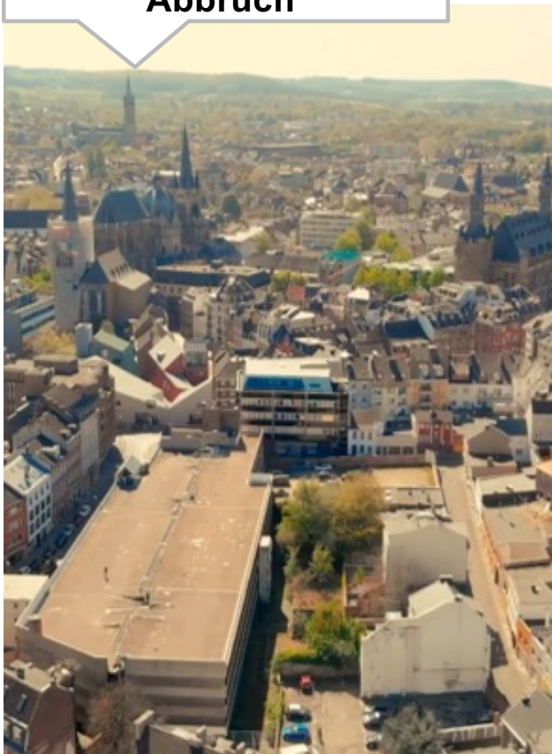
Parkhaus vor dem Abbruch
